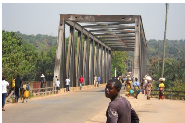
Pont sur la rivière Mbuji-Mayi.
