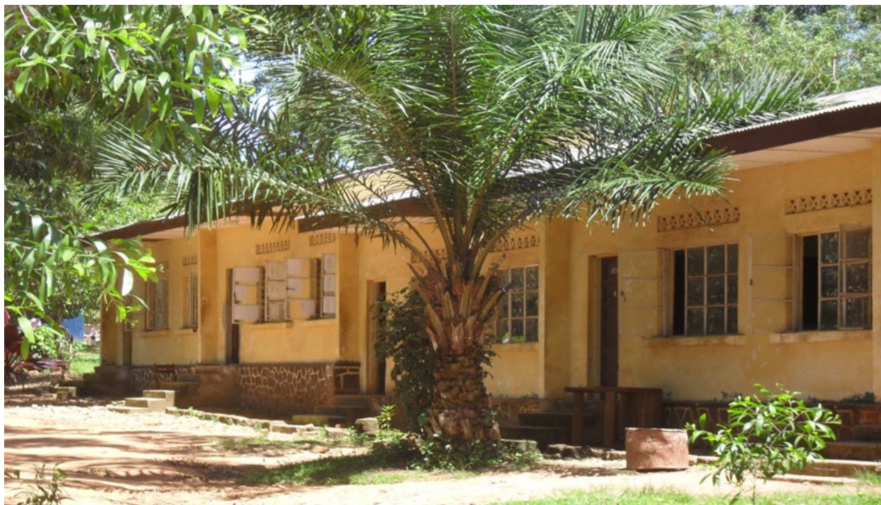
Un bâtiment de l'UOM. (Photo équipe locale, 2011.)
