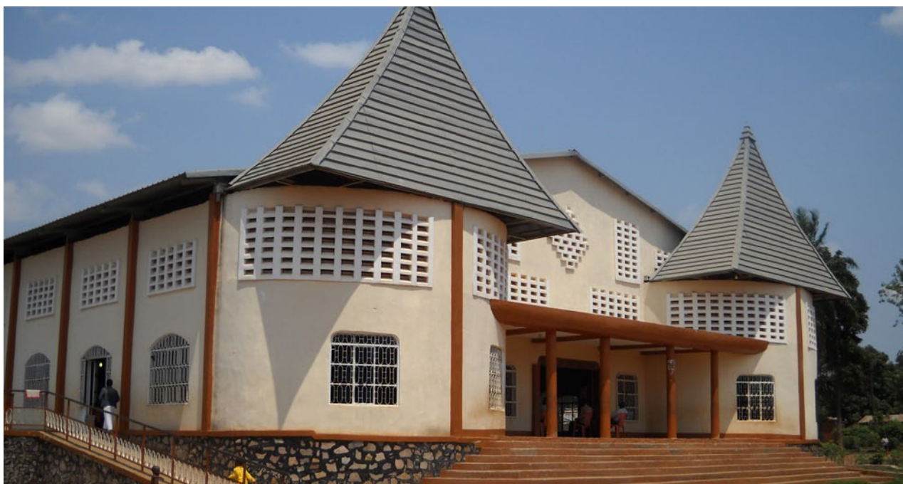
Église pentecôtiste de la commune de la Muya à Mbuji-Mayi. (Photo équipe locale, 2011.)
