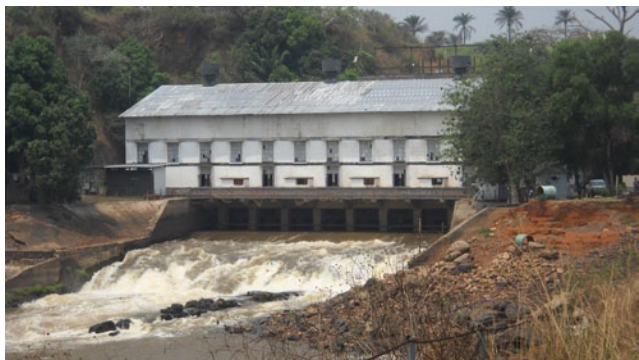
Centrale hydroélectrique de Tshiala.
