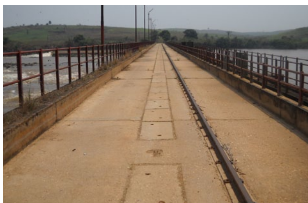
Pont sur la rivière Lubilanji à Tshibila.
