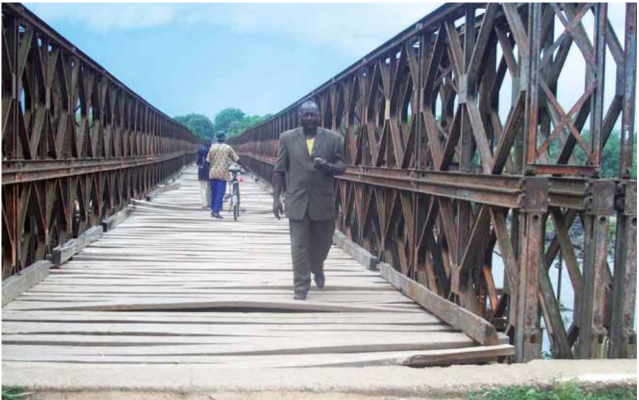
Pont jeté sur la rivière Uele au niveau de Niangara. (Photo équipe locale, 2010.)
