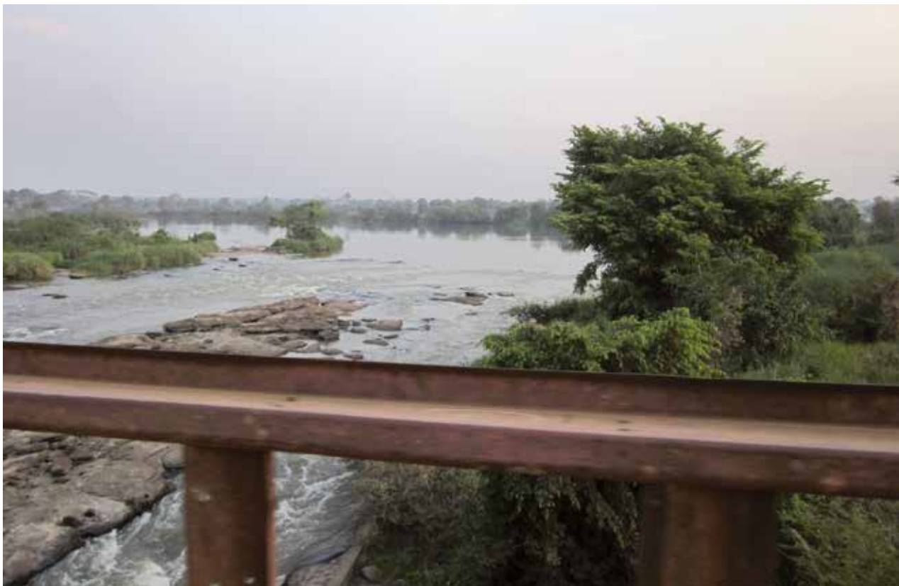
Pont sur la rivière Kibali. Photo équipe locale, 2011.
